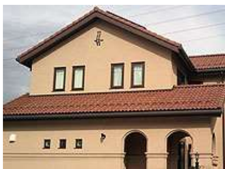
施工例:アンバー
