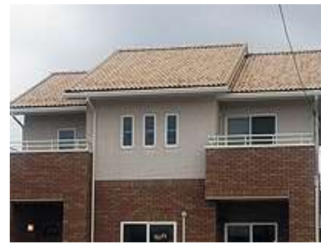
施工例:アイボリー
