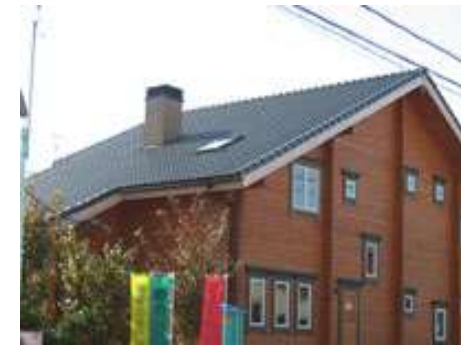
施工例:マウントグリーン
